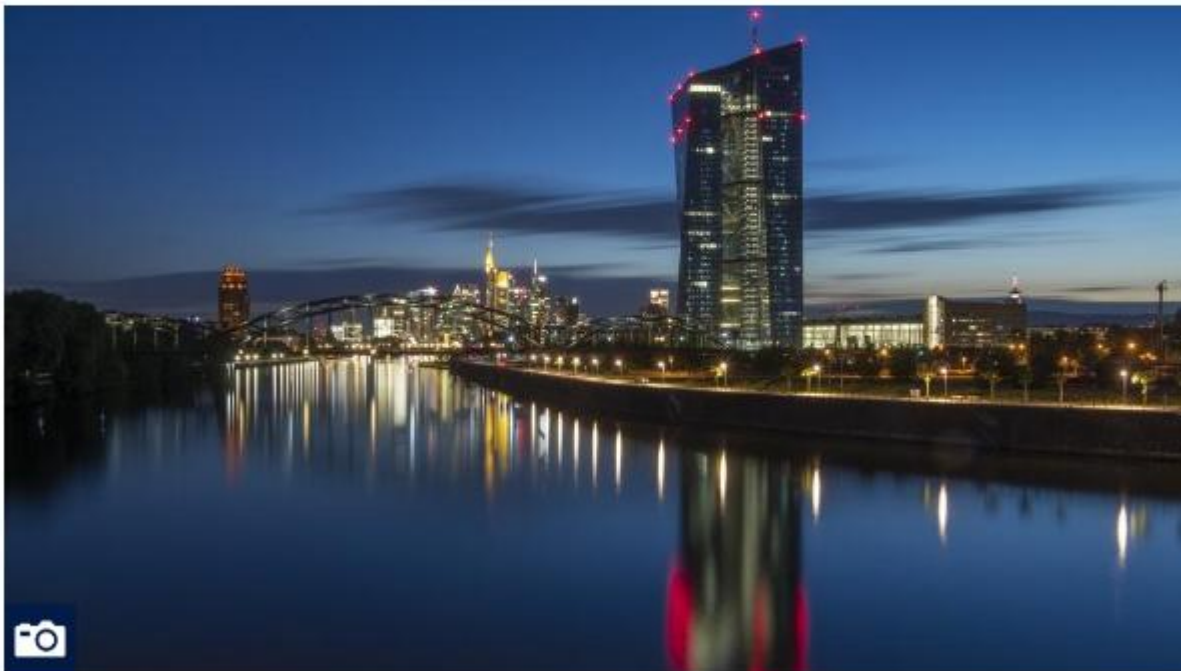
Das EZB-Gebäude in Frankfurt - in Karlsruhe steht die Politik der EZB vor Gericht.
